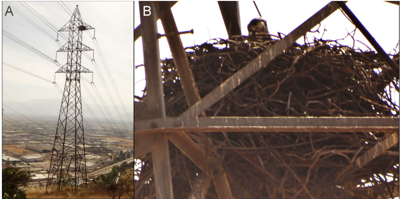
Figura 1. Nido de águila ( Geranoaetus melanoleucus ) monitoreado entre 2015 y 2021 en la ciudad de Santiago, Chile central. A. Nido de águila construido en la cruceta superior de una torre de transmisión eléctrica de alta tensión ubicada en la ladera de un cerro periurbano. B. Hembra incubando.
